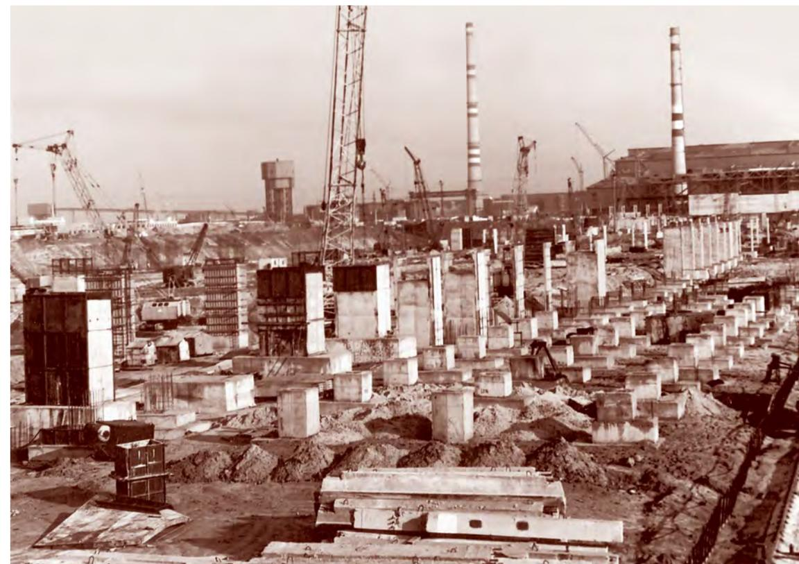
сооружён монтажно-транспортный пролёт с поперечными проездами. Производство работ по фундаментам под оборудование и тоннелям, находящимся в монтажно-транспортном пролёте, выполнялось во вторую очередь, после окончания монтажа опорных конструкций.
